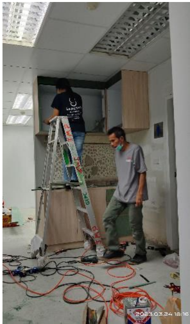
งานติดตั้งตู้ Pantry & ลามิเนตและผนัง Backing
