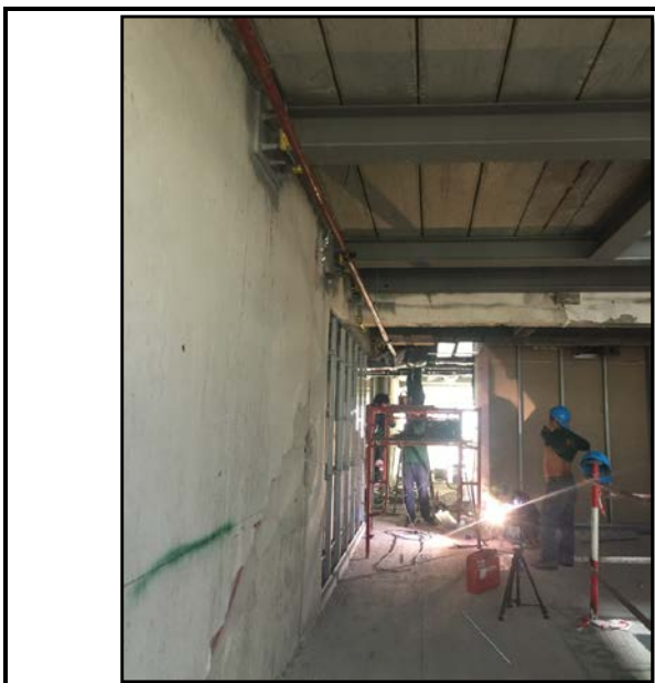
Activity ติดตั้งท่อเมนสปริงเกอร์ Floor 13 Date : 23 December 2019
