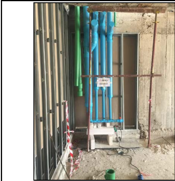
Activity ติดตั้งท่อ CW,HWS Floor 8-14 Date : 23 December 2019
