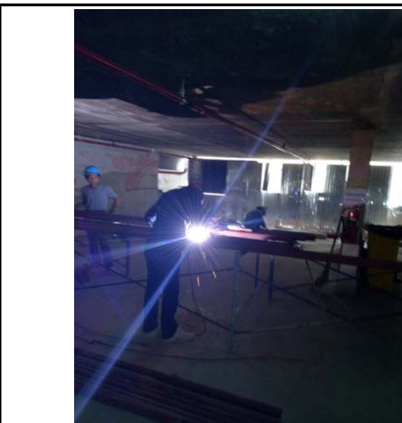
Activity ติดตั้งท่อสปริงเกอร์ขนาดย่อย Floor P4 Date : 11 June 2563
