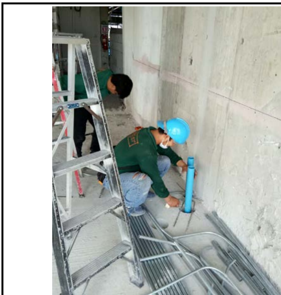
Activity ติดตั้งท่อห้องตัวอย่าง Floor 8 Date : 11 June 2563
