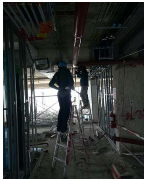
Activity ติดตั้งท่อ Main สปริงเกอร์ Floor 12 Date : 9 July 2563
