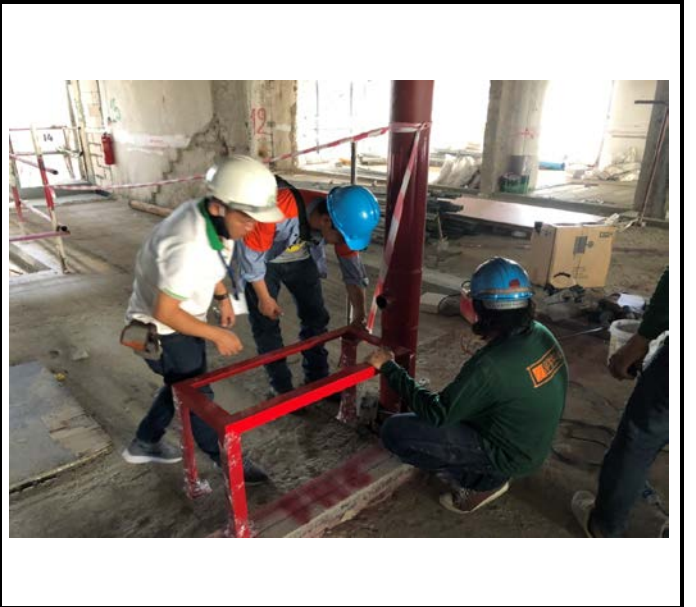
Activity ติดตั้งตู้ดับเพลิง Floor 6-16 Date : 27 July 2563
