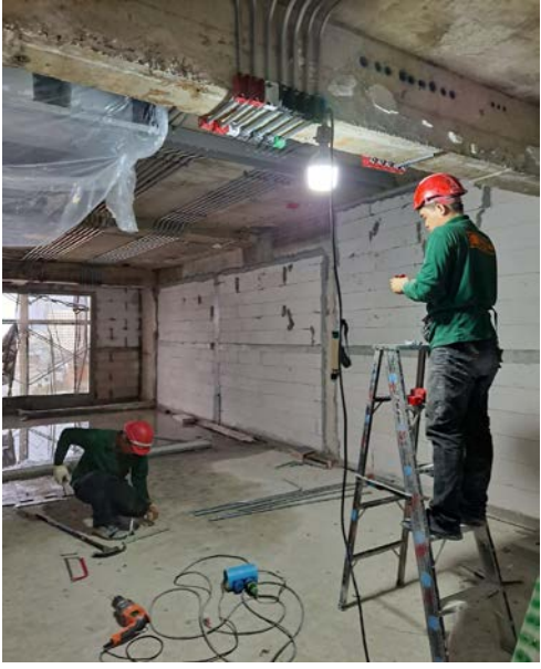
Activity เดินท่อไฟฟ้าเหนือฝ้าบริเวณห้องพัก Floor 11 Date : 5 October 2563
