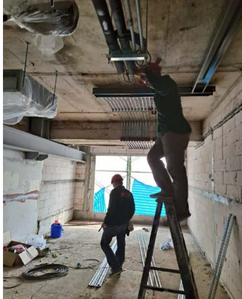
Activity เดินท่อไฟฟ้าเหนือฝ้าบริเวณห้องพัก Floor 11 Date : 5 October 2563
