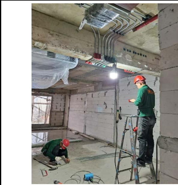
Activity เดินท่อไฟฟ้าเหนือฝ้าบริเวณห้องพัก Floor 11 Date : 5 October 2563
