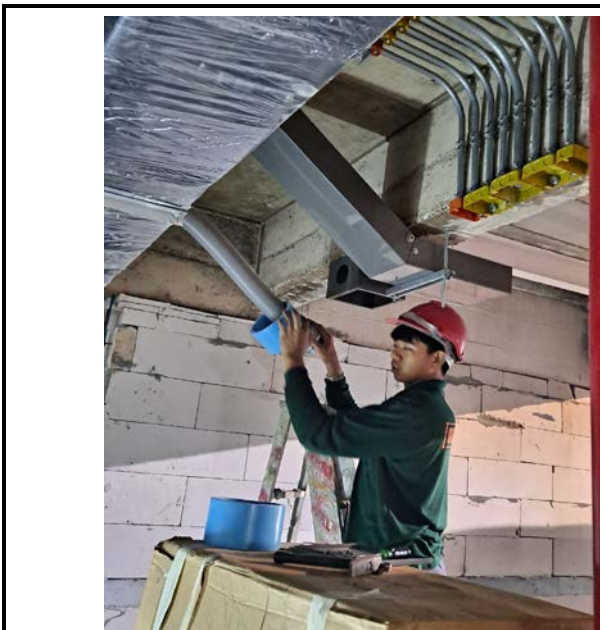
Activity ติดตั้ง BOX OUT บริเวณห้องไฟฟ้า Floor 8 Date : 6 October 2563
