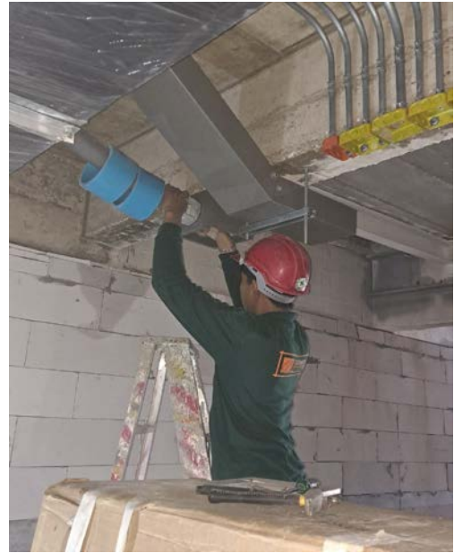
Activity ติดตั้ง BOX OUT บริเวณห้องไฟฟ้า Floor 8 Date : 6 October 2563
