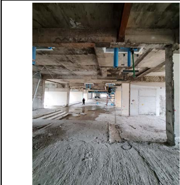
Activity เดินท่อเมน S,W,V Floor P5 Date : 10 October 2563
