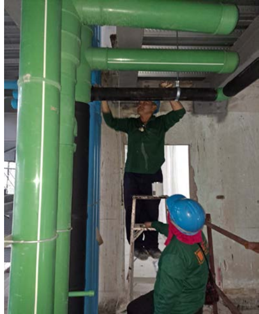
Activity หุ้มฉนวนท่อ HW,CW บริเวณ Corridor Floor 12 Date : 10 October 2563
