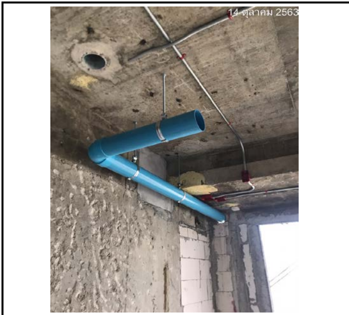
Activity เดินท่อดูดอากาศบริเวณห้องพัก Floor 09 Date : 14 October 2563
