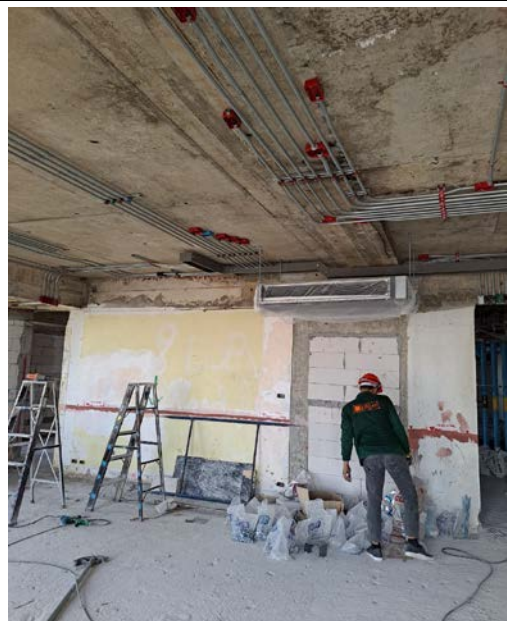
Activity เดินท่อไฟฟ้าเหนือฝ้าบริเวณห้องพัก Floor 10 Date : 15 October 2563
