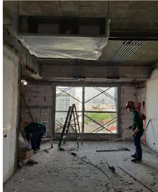
Activity เดินท่อไฟฟ้าเหนือฝ้าบริเวณห้องพัก Floor 10 Date : 15 October 2563
