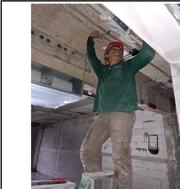
Activity เดินท่อไฟฟ้าเหนือฝ้าบริเวณห้องพัก Floor 10 Date : 16 October 2563
