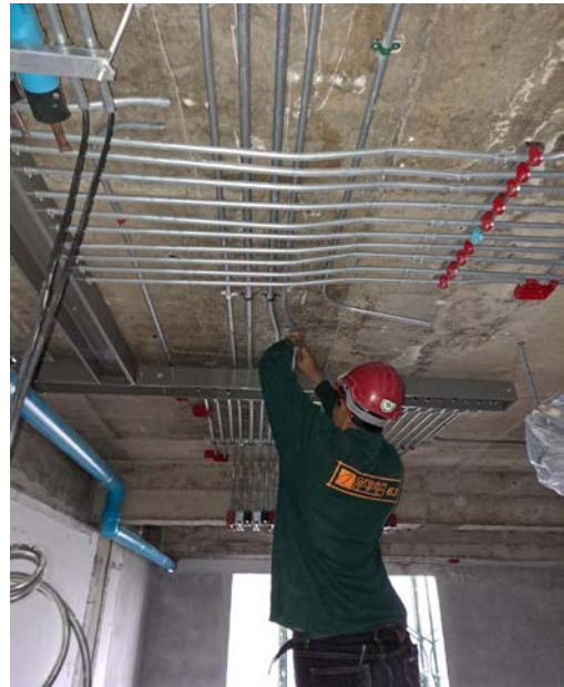
Activity เดินท่อไฟฟ้าเหนือฝ้าบริเวณห้องพัก Floor 10 Date : 16 October 2563
