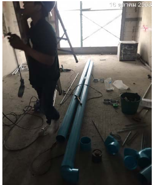
Activity เดินท่อดูดอากาศบริเวณห้องพัก Floor 09 Date : 16 October 2563
