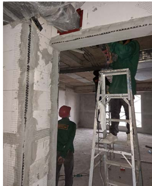
Activity เดินท่อไฟฟ้าเหนือฝ้าบริเวณห้องพัก Floor 10 Date : 16 October 2563
