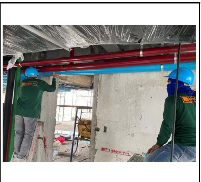
Activity เดินท่ออากาศ Floor 16 Date : 22 October 2563
