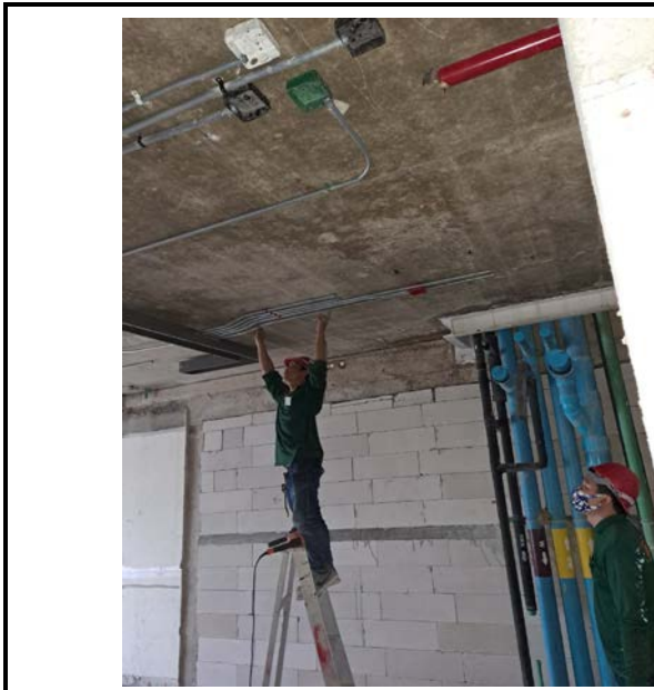
Activity เดินท่อไฟฟ้าเหนือฝ้าบริเวณห้องพัก Floor 14 Date : 23 October 2563
