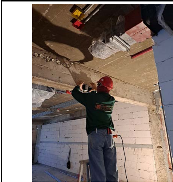
Activity เดินท่อไฟฟ้าเหนือฝ้าบริเวณห้องพัก Floor 13 Date : 23 October 2563
