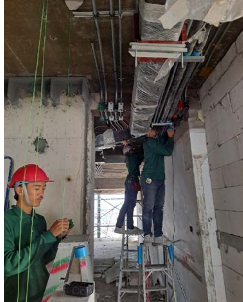
Activity เดินท่อไฟฟ้าเหนือฝ้าบริเวณห้องพัก Floor 13 Date : 23 October 2563
