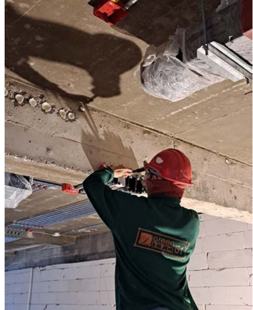
Activity เดินท่อไฟฟ้าเหนือฝ้าบริเวณห้องพัก Floor 13 Date : 23 October 2563
