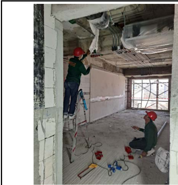
Activity เดินท่อไฟฟ้าเหนือฝ้าบริเวณห้องพัก Floor 14 Date : 24 October 2563
