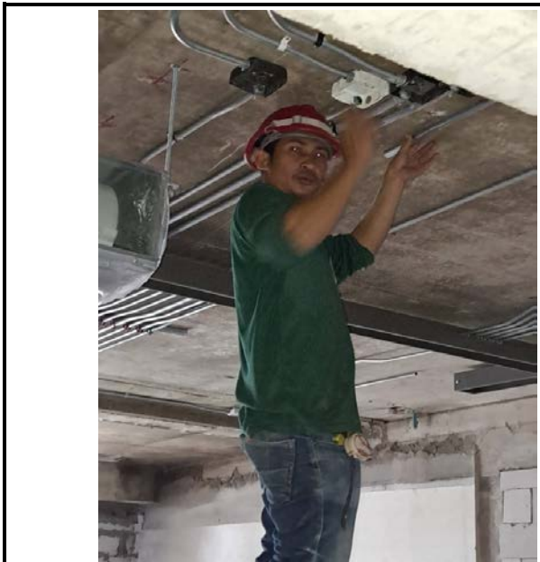
Activity เดินท่อไฟฟ้าเหนือฝ้าบริเวณห้องพัก Floor 14 Date : 24 October 2563
