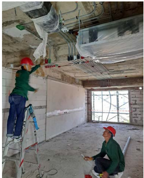
Activity เดินท่อไฟฟ้าเหนือฝ้าบริเวณห้องพัก Floor 14 Date : 24 October 2563
