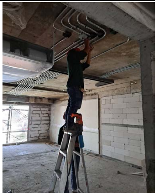
Activity เดินท่อไฟฟ้าเหนือฝ้าบริเวณห้องพัก Floor 14 Date : 24 October 2563
