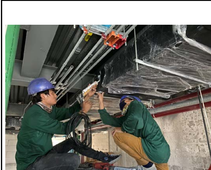
Activity เดินท่อดูดอากาศบริเวณห้องพัก Floor 11 Date : 2 November 2563
