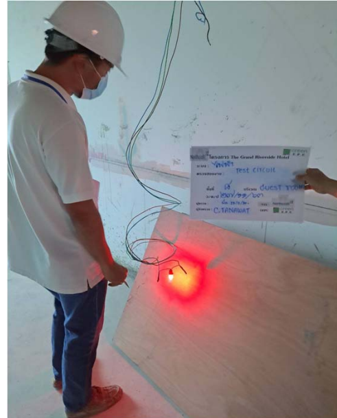
Activity ตรวจสอบงานติดตั้งและทดสอบระบบ Emergency Power Receptacle & Emergency Floor 08 Date : 27 November 2563
