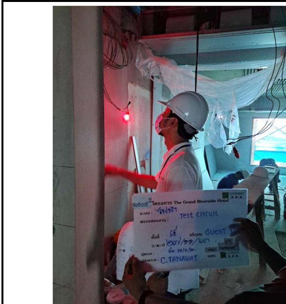
Activity ตรวจสอบงานติดตั้งและทดสอบระบบ Emergency Power Receptacle & Emergency Floor 08 Date : 27 November 2563
