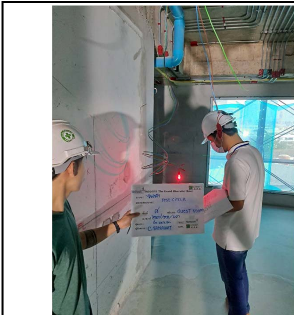
Activity ตรวจสอบงานติดตั้งและทดสอบระบบ Emergency Power Receptacle & Emergency Floor 08 Date : 27 November 2563
