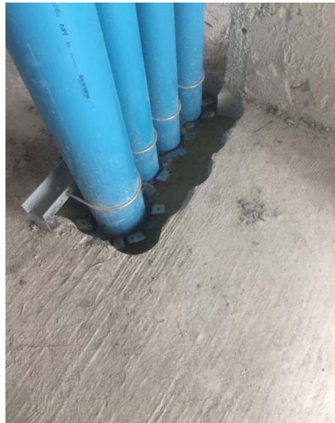
Activity ติดตั้ง Fire Barrier บริเวณ Shaft Floor 9,10 Date : 13 December 2563
