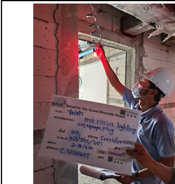
Activity ตรวจสอบงานระบบไฟฟ้า Floor 11 Date : 18 December 2563
